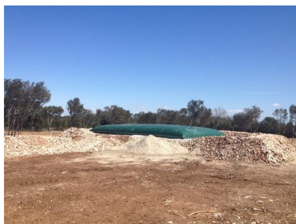
Réserve de 120 m 3 d'eau pour la lutte contre l'incendie sur l'emprise du projet
